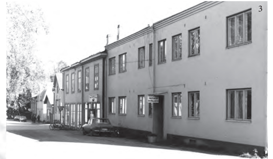
Maakunnan kiviosa oli hieman puosaa korkeampi. Porrastus johtuu osin siitä, että Keskuskatu nousee etelään.
