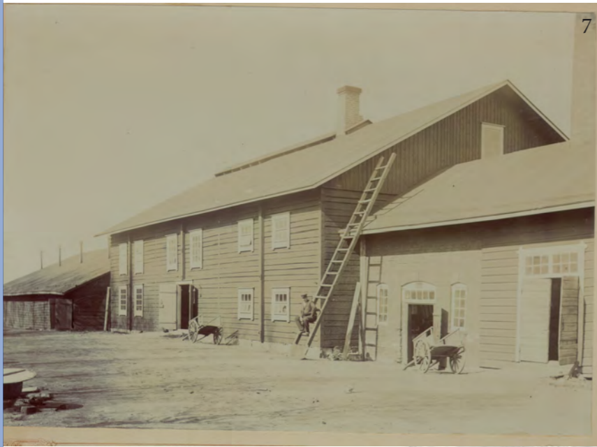
Olutpanimon rakennuksia Loimijoen varressa.
